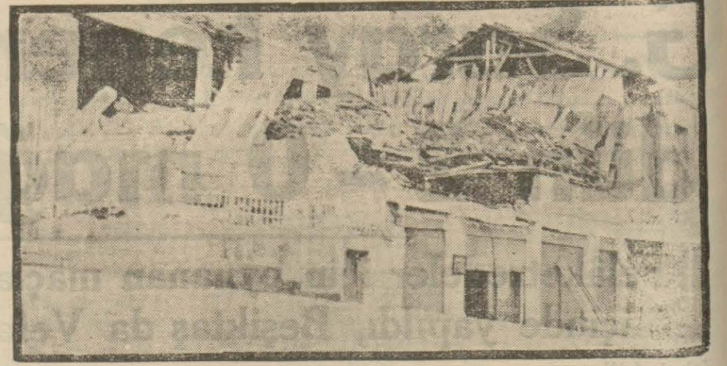
Çarşambada zelzeleden yıkılan evlerden bir kaç
